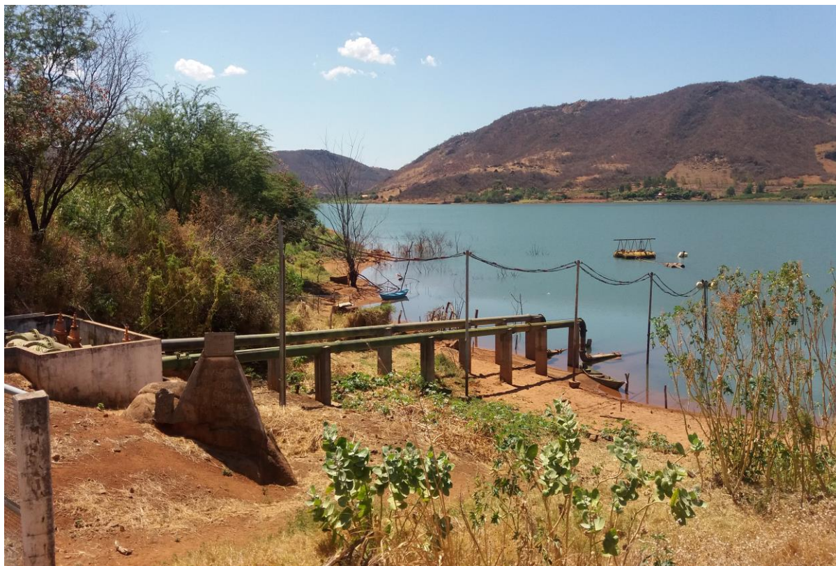
Figura 8 – Captação na Barragem de Ceraíma-Guanambi
